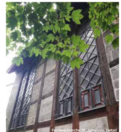
Fachwerkkirche St. Johannis, Detail
